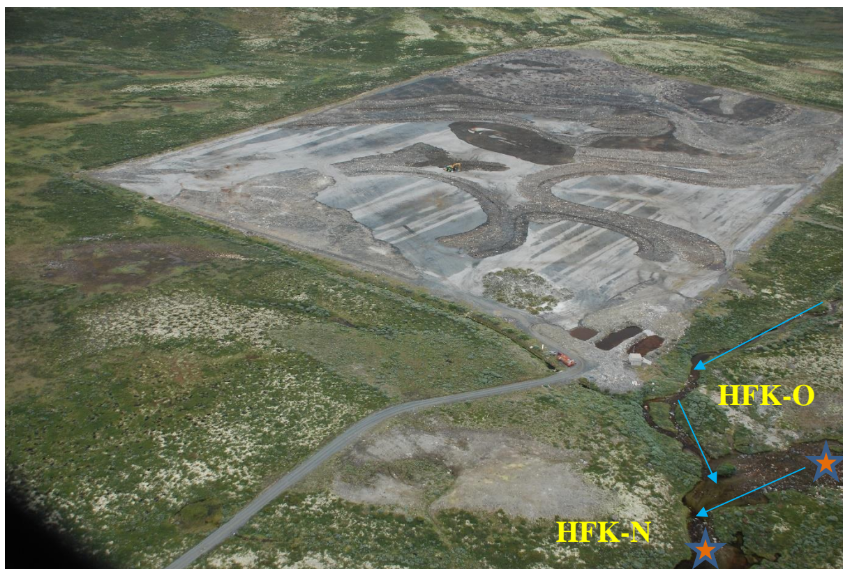
Figur 14: Foto av overflate arronderingen av HFK-sletta i 2013 (Forsvarsbygg). Sedimentasjonsdammene er fjernet og den nordøstre grøfta er fjernet og vannspeilet på Stormyra er tilbakeført. Figuren viser også ca. plasseringen av overvåkingspunktene i Grisungbekken (stjerner).
