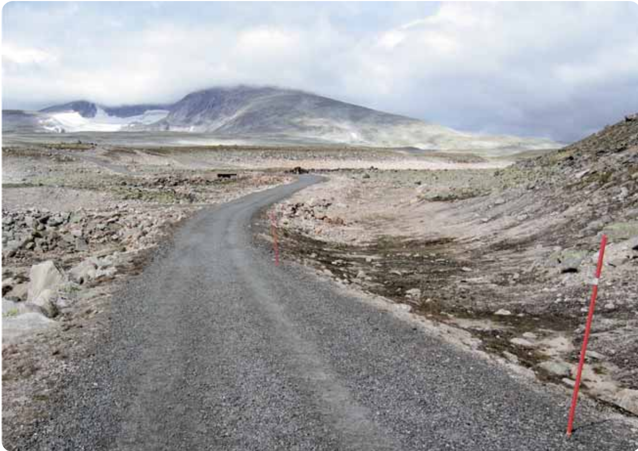
Indre del av Snøheimvegen. Foto: Odd-Erik Martinsen, Forsvarsbygg
