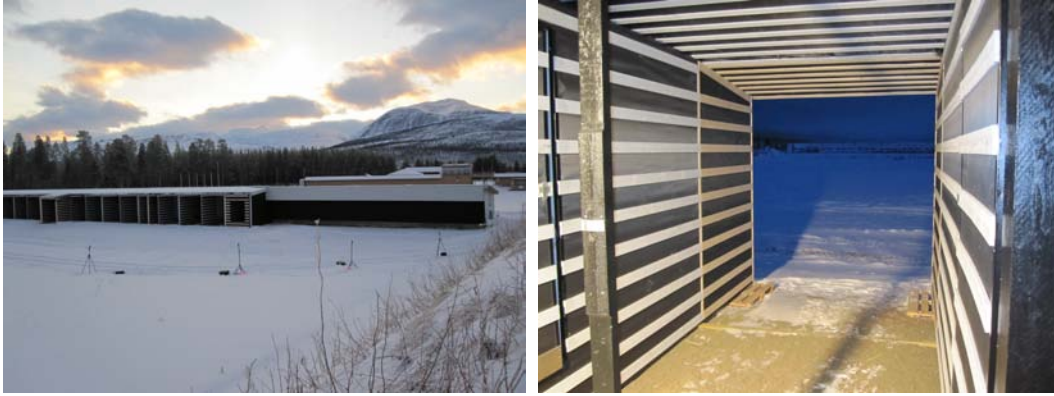
Måleoppsett og testobjekter i fm. støytiltak på standplasshus. Foto: Forsvarsbygg
