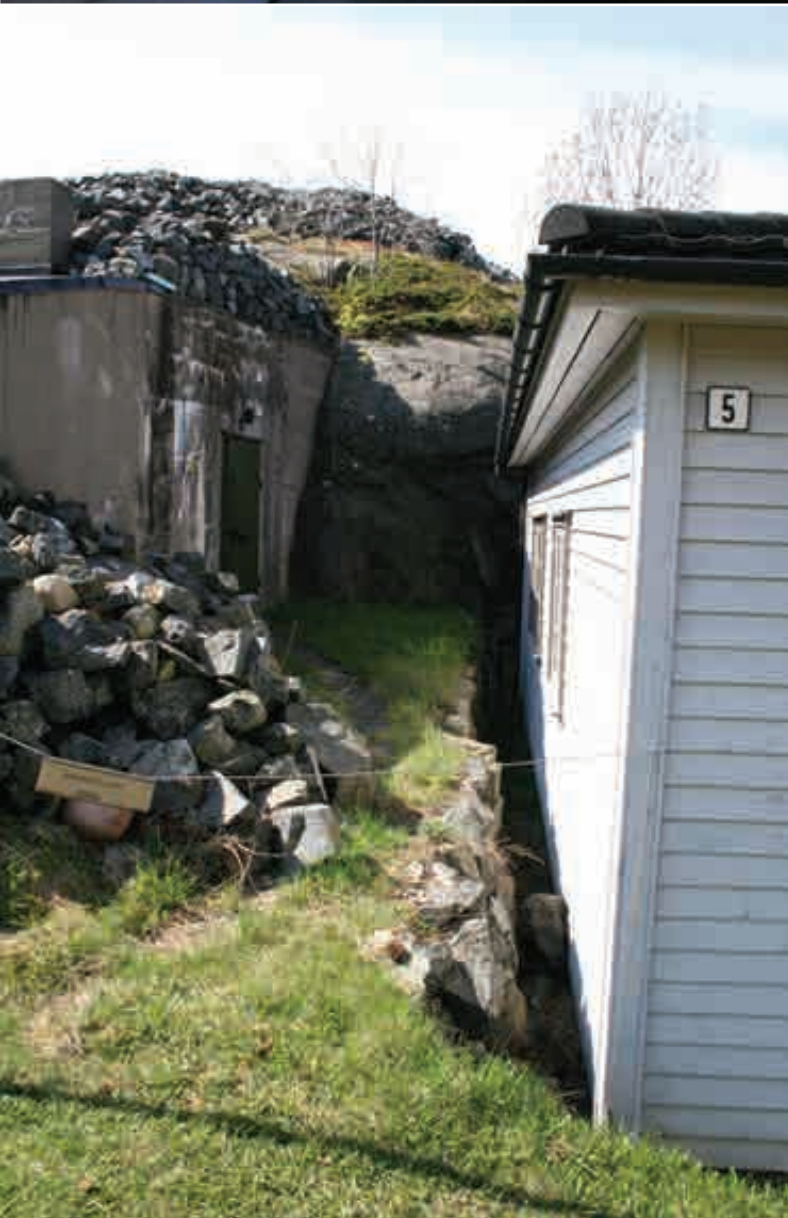
Fasade sør med bunker 1015 til venstre
