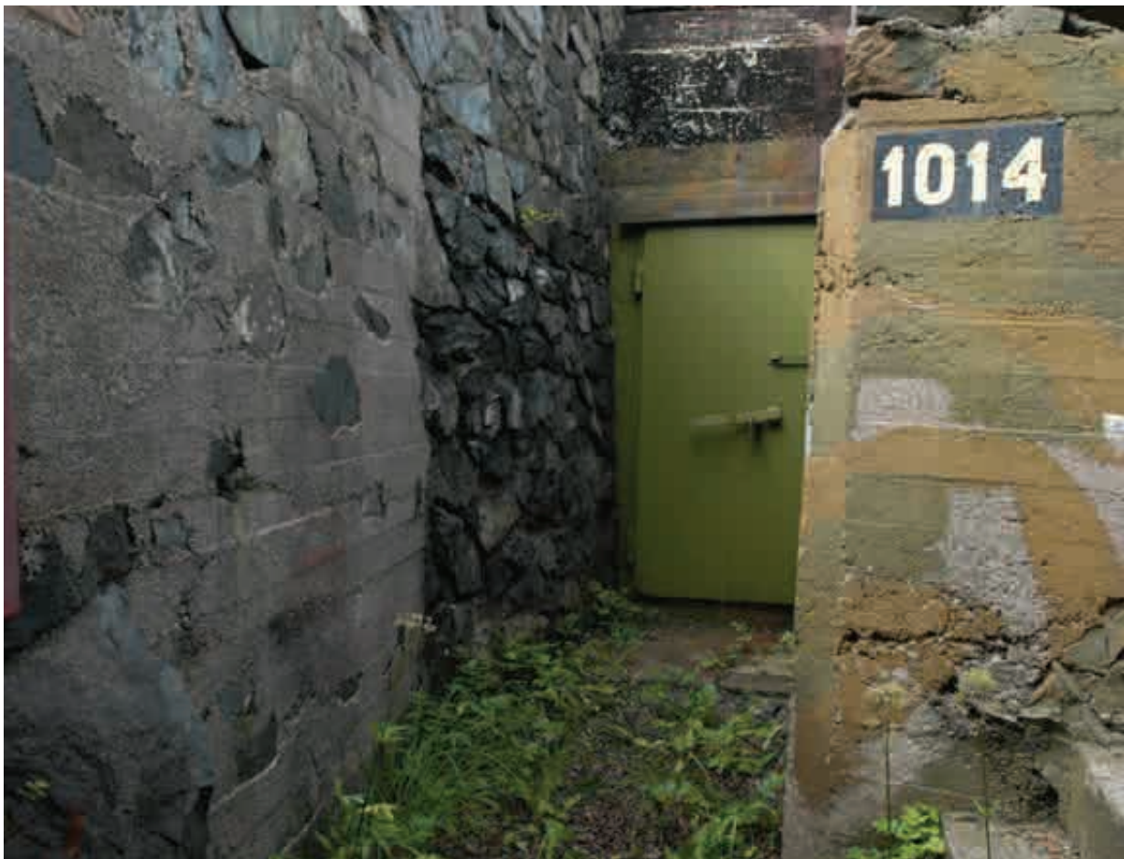
Inngang med støpte vegger malt i kamuflasjefarger
