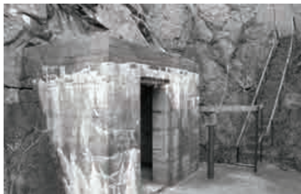
Ammunisjonsrom i forgrunn med trapp opp til stillingene 1034 og 1035
