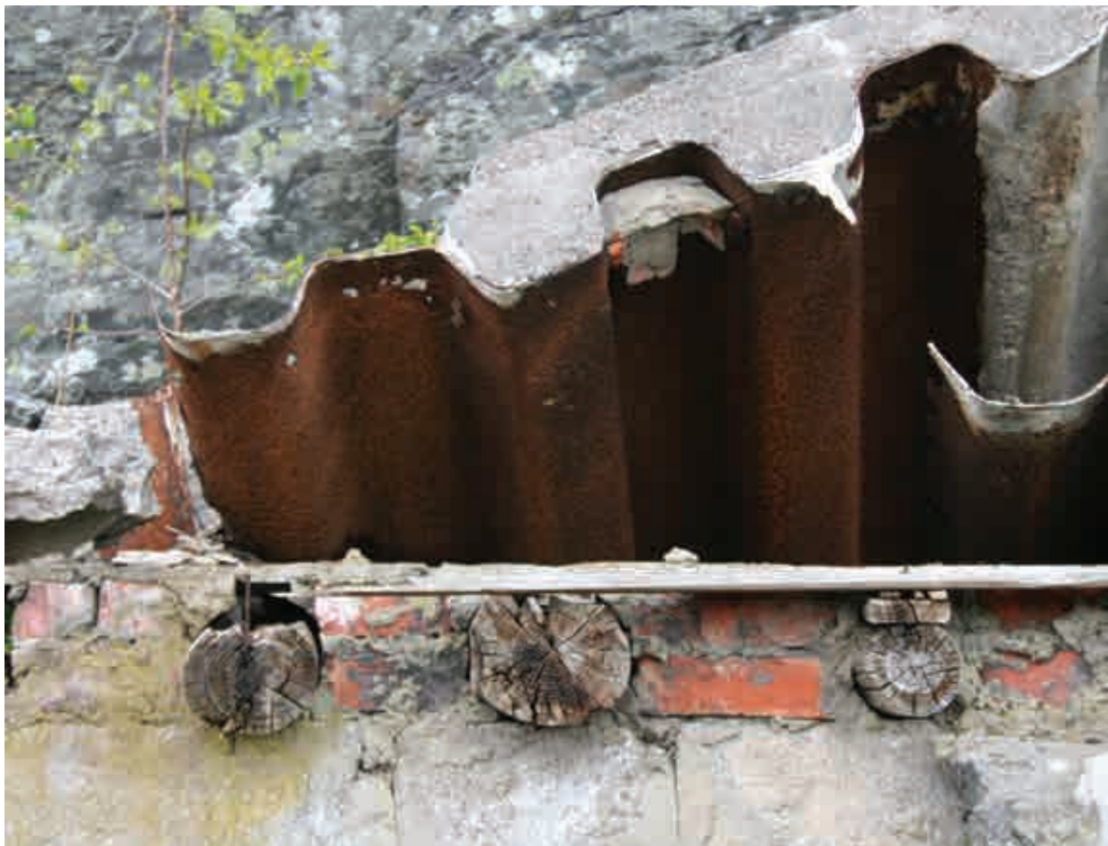
Detalj av takkonstruksjon
