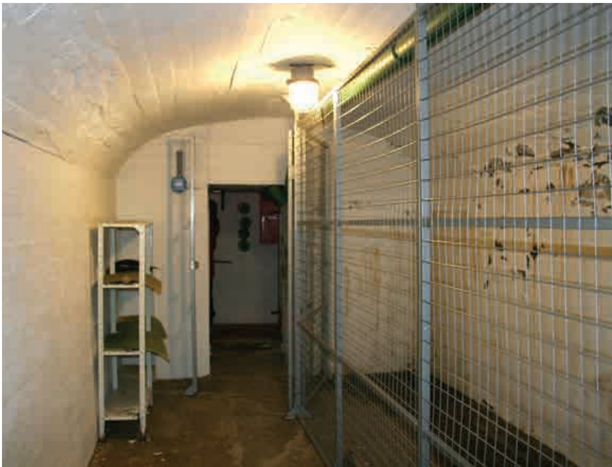
Stålgitter deler rommet i to. Ammunisjonslager på høyre side
