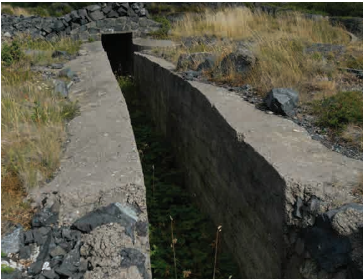
Løpegrav i støpt betong fra stilling 1045 til bunker 1051
