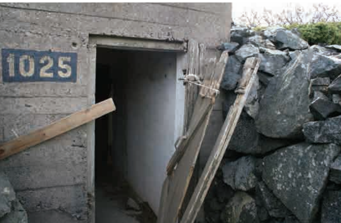
Inngang til bunker fra nordøst
