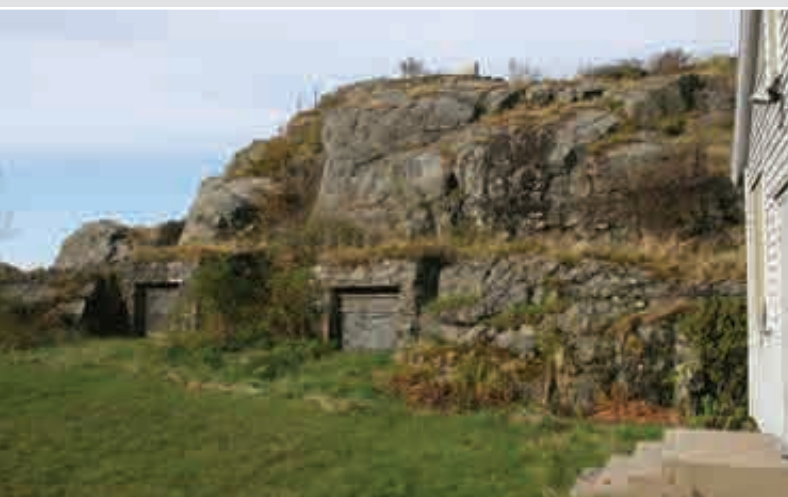
To ammunisjonsrom rett utenfor depotbrakk
