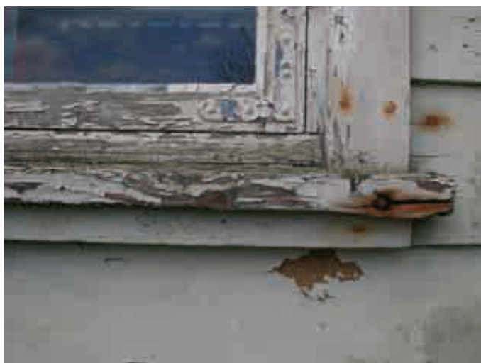
Detalj vindu - råteskade og rust, fasade nordvest
