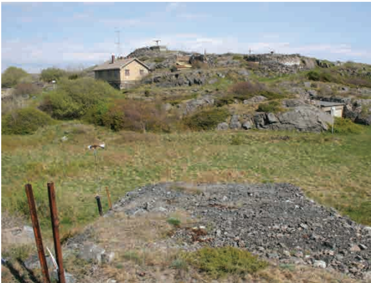
I forgrunnen tak til inventar nr 1021. I bakgrunnen bygning 0004 og diverse stillinger
