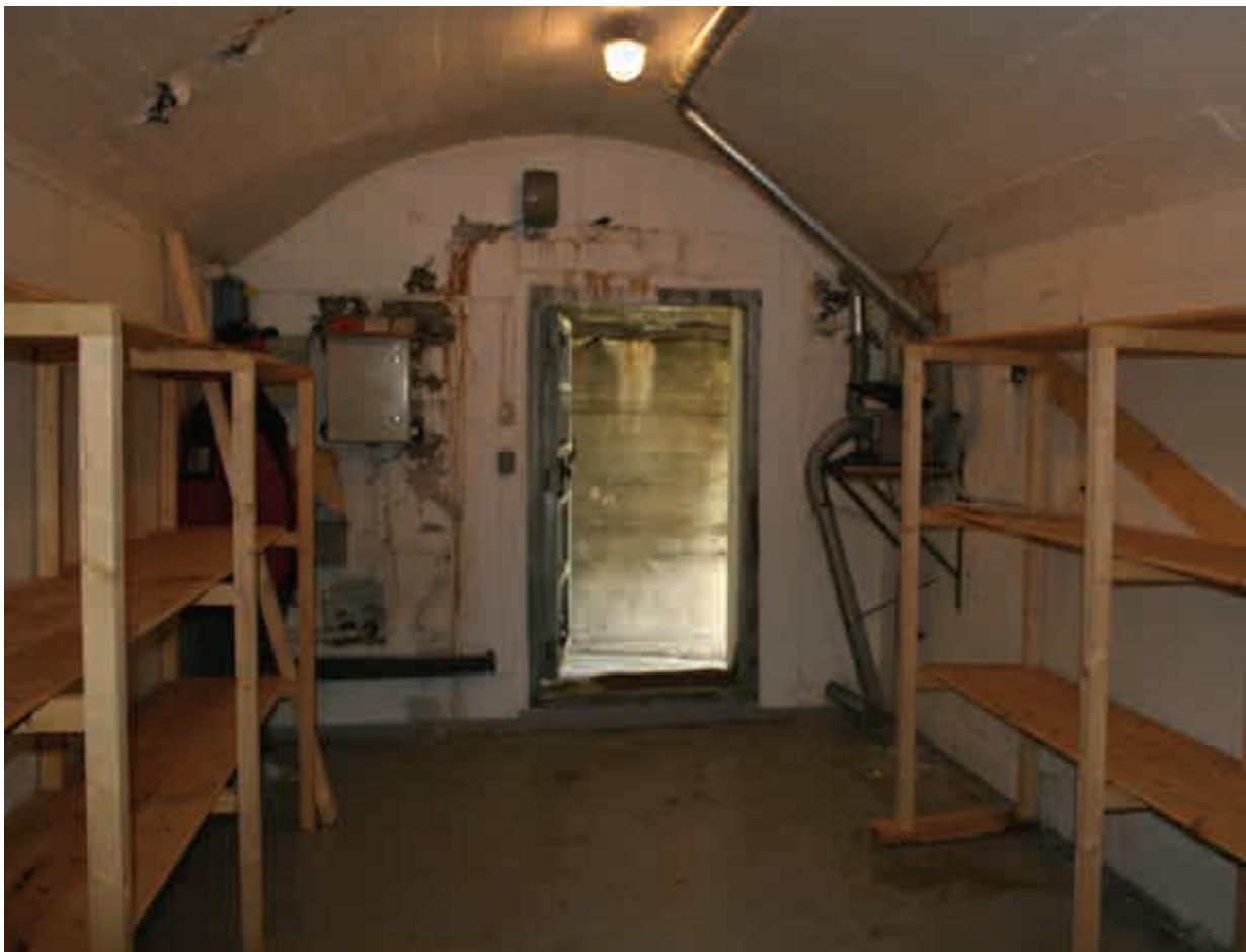
Interiør i forlegningsbunker
