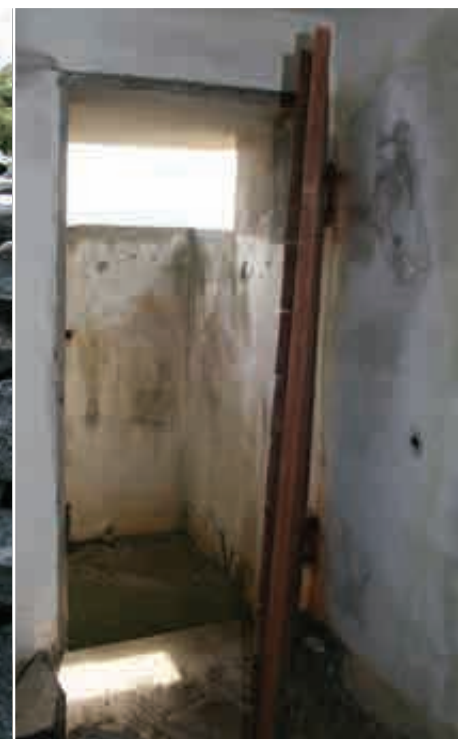
Opprinnelig tysk dør mellom rommene
