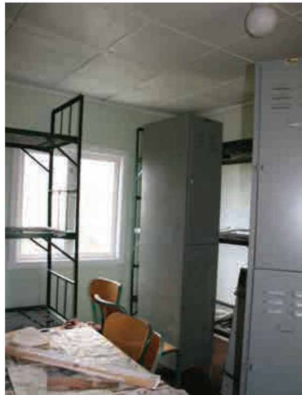
Rom 003, forlegning. Opprinnelige himlingsplater og listverk
