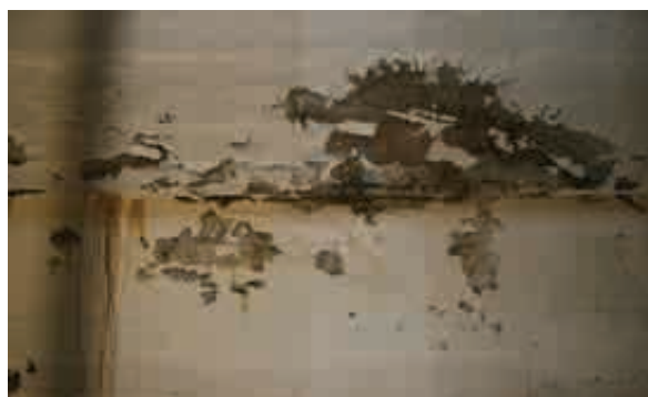
Fuktintregning i skjøtet mellom vegg og tak
