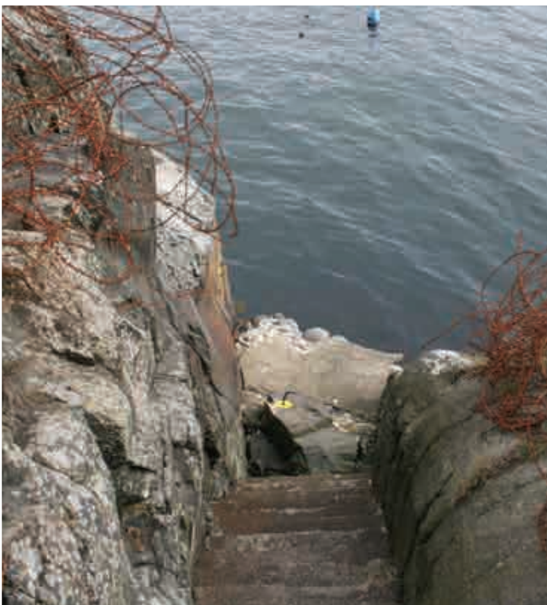
Bryggedekke er skadet. Eventuelt kan gjenstøpes og steinfylling sikres.
