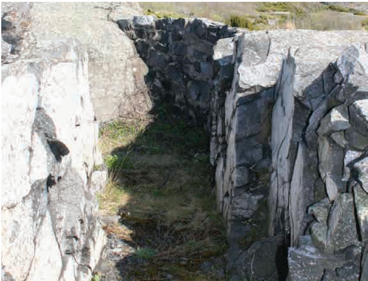
Løpegrav bygget med utsprengt stein går mellom de tre stillingene
