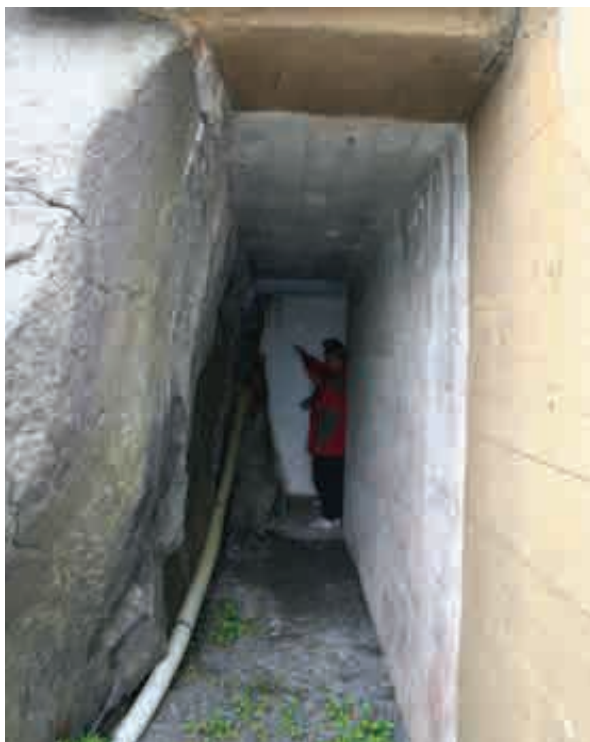
Overdekket gang mellom bunkerens vestre fasade og fjell
