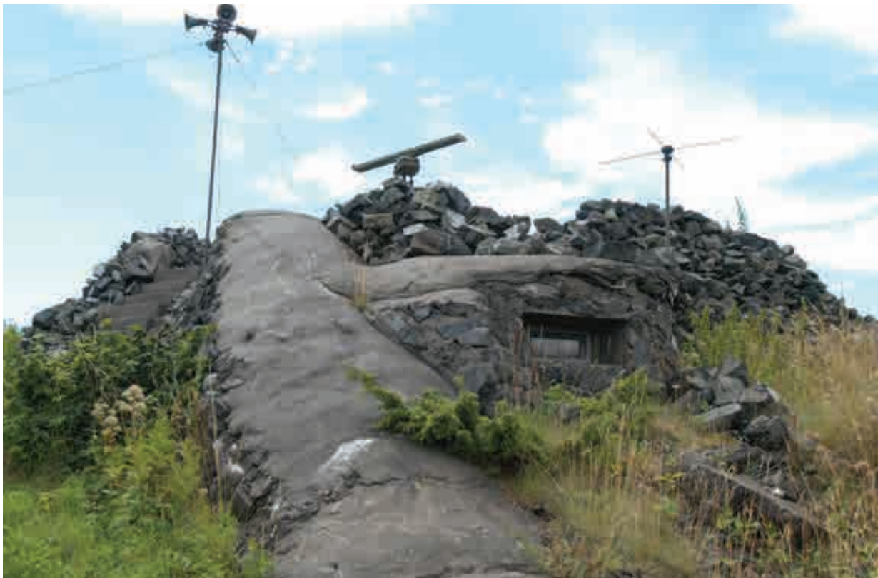
Til høyre observasjonsrom. I forgrunn tak over inngangstunnel
