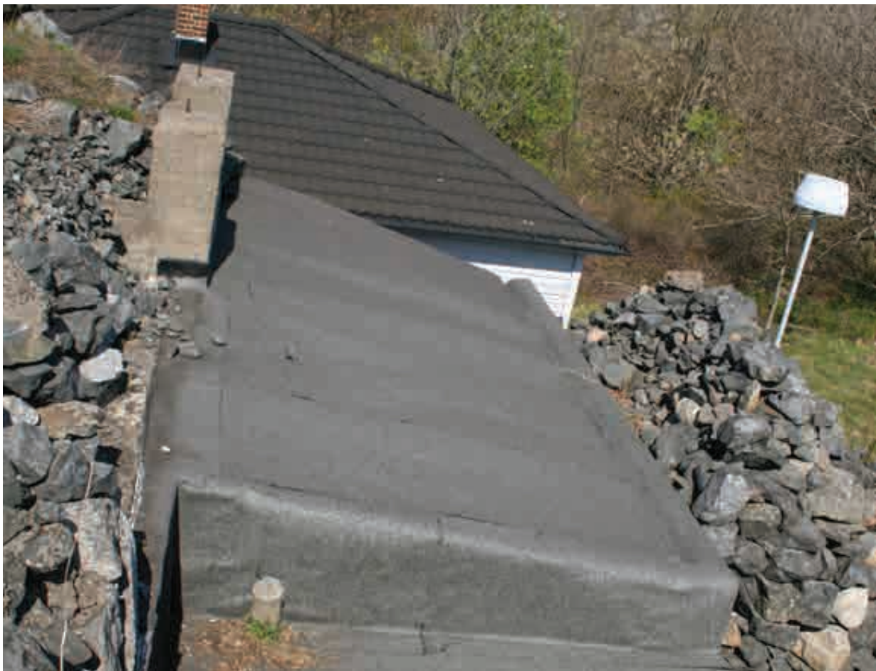
Steinmantel til høyre bør legges tilbake over papptekket
