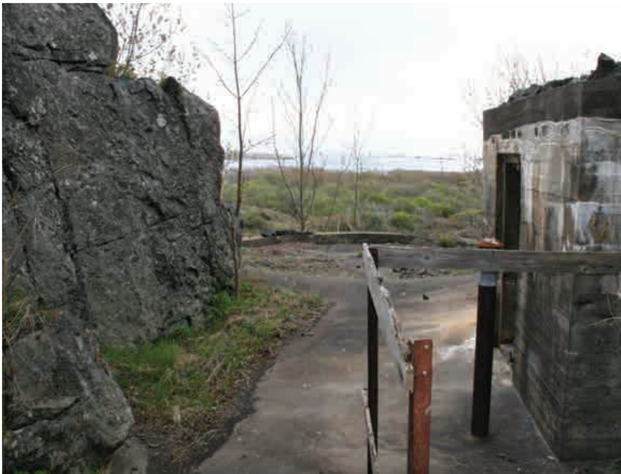
Luftvernstilling med ammunisjonsrom til høyre på taket av bunker 1036
