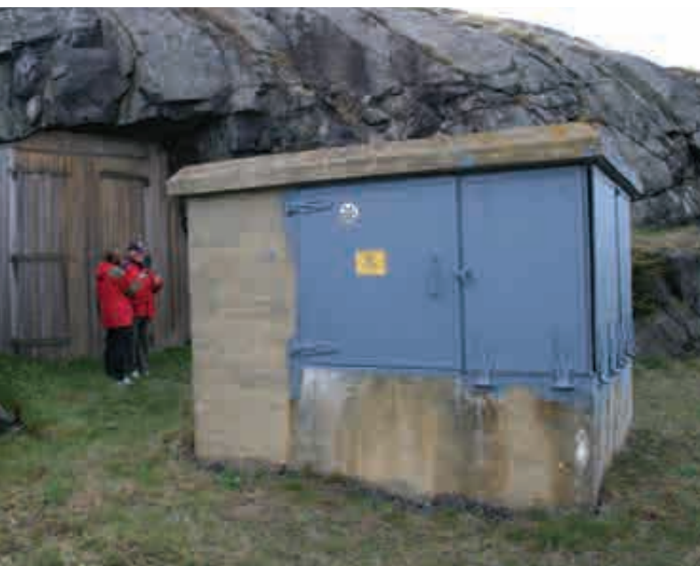
Til venstre i bildet - tofløyet dør med inngang til tunnel og lyskasterens fasade mot nord
