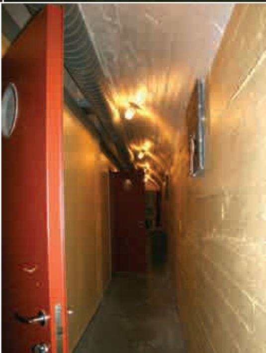
Avflassende plastmaling i rom 001
