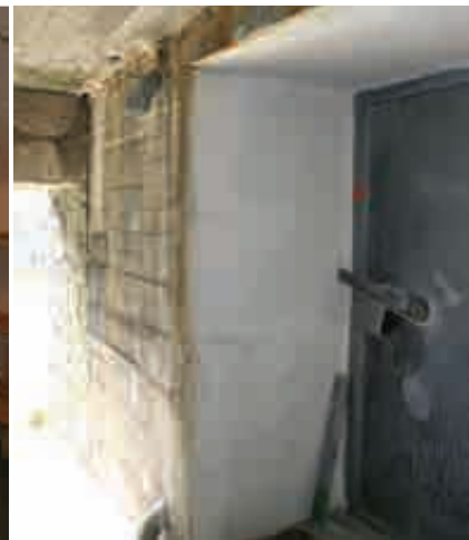
Inngangsdør i galvanisert stål
