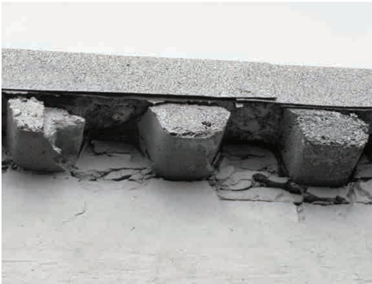
Detalj - støpt tak på korrugerte stålplater
