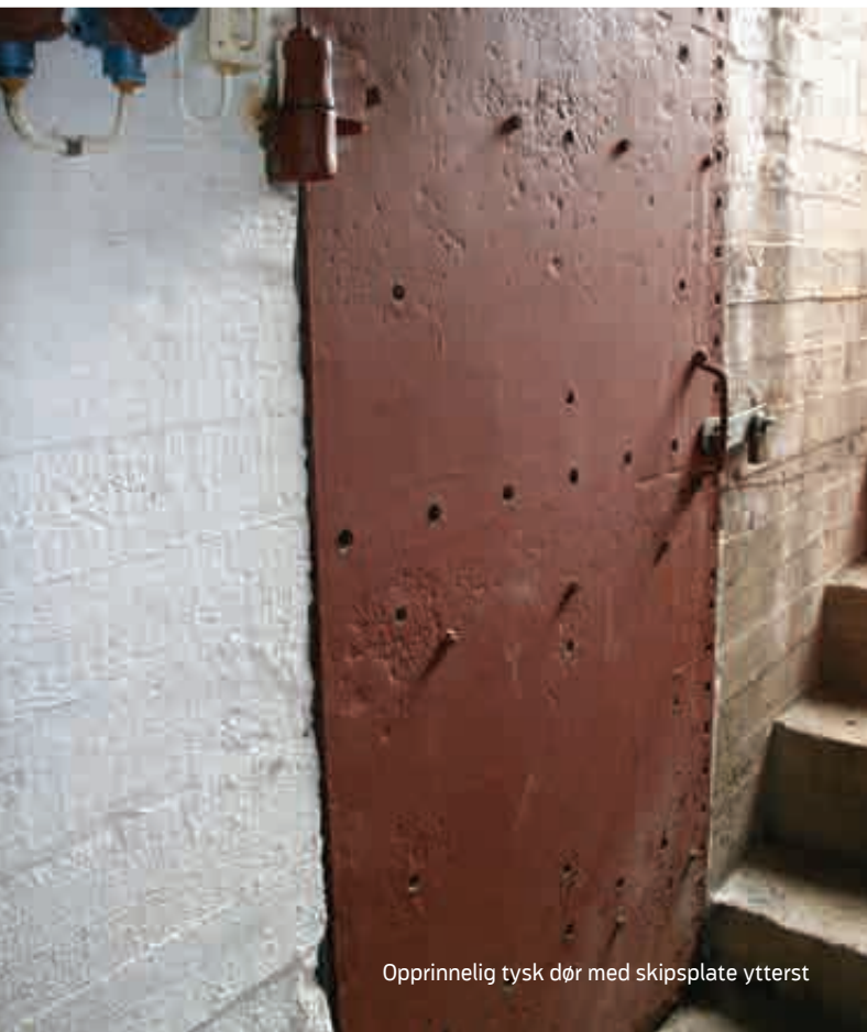
Døren består av horisontale og vertikale kryssplater, og dekket med skipsplate
