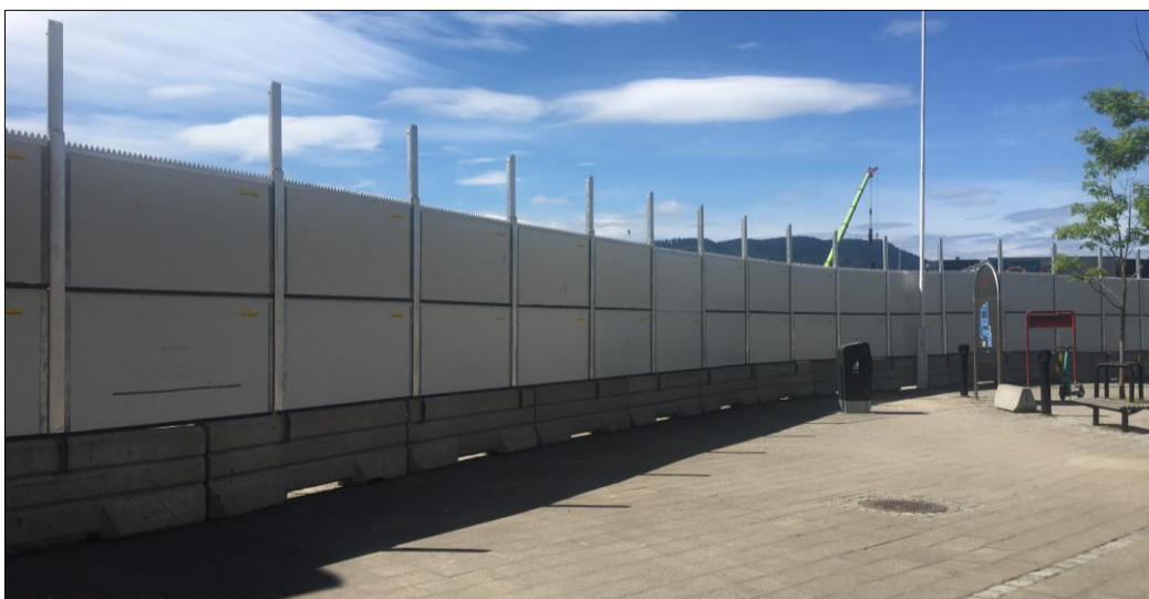
Figur 3: Eksempel på flyttbar støyskjerm som kan vurderes benyttet rundt vannmeislingen.
