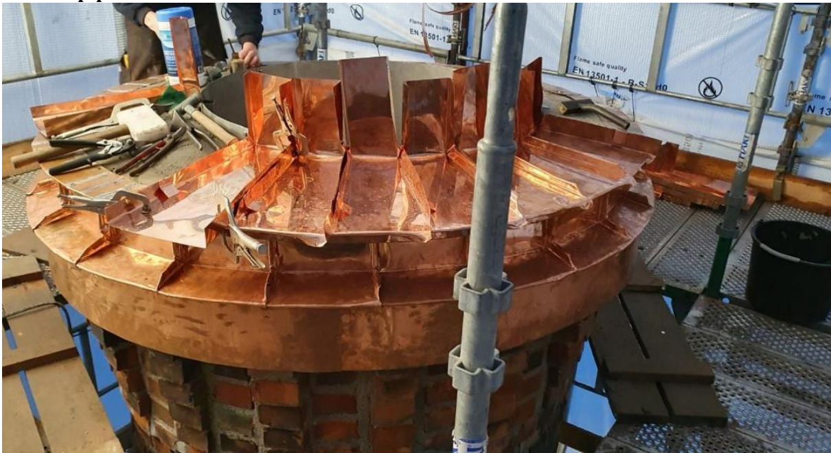
Fra monteringen av pipehatt i kobber. Blikkenslager Ulf Hansen AS.
