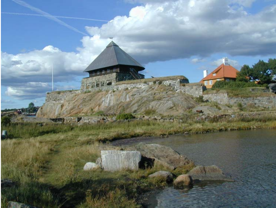
Citadellet på Citadeløya. Ballastplantene vokser i forkant av berget/muren.
