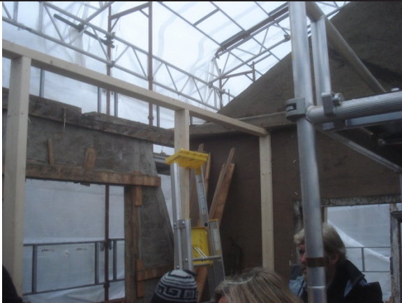
11.3.2009 Tak og vinduer demontert.
