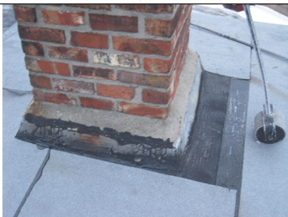
Papp lagt inntil piper. Deretter med oppbrett.
