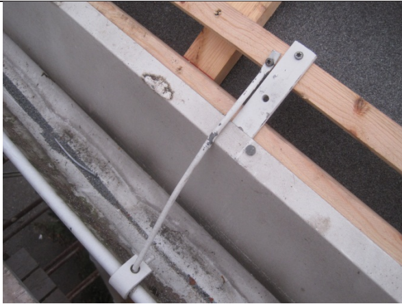
Remonterte takrenner og -kroker
