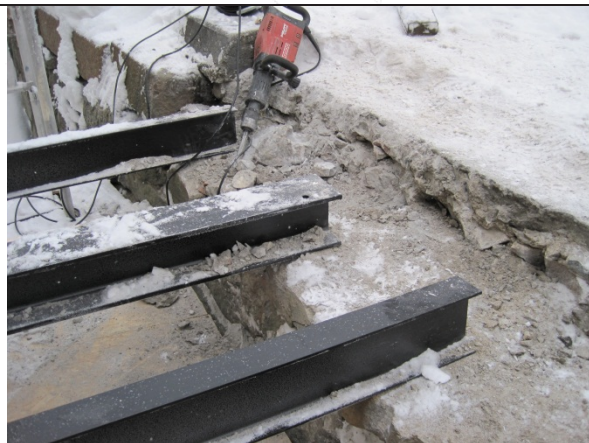
24.2.2010 Nye bjelker utlagt. Gamle bjelker til deponi.
