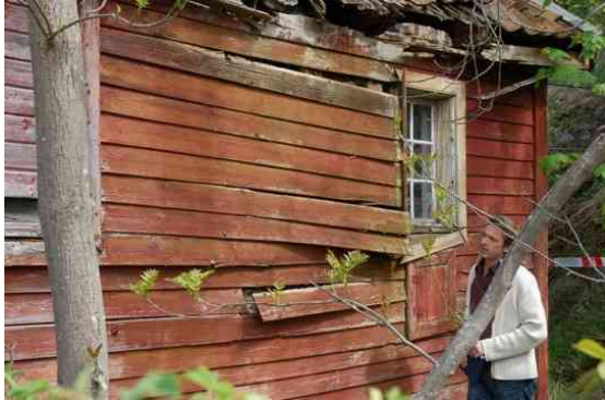
Bilde før oppstart
