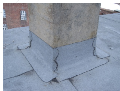
Papp lagt inntil piper. Deretter med oppbrett.
