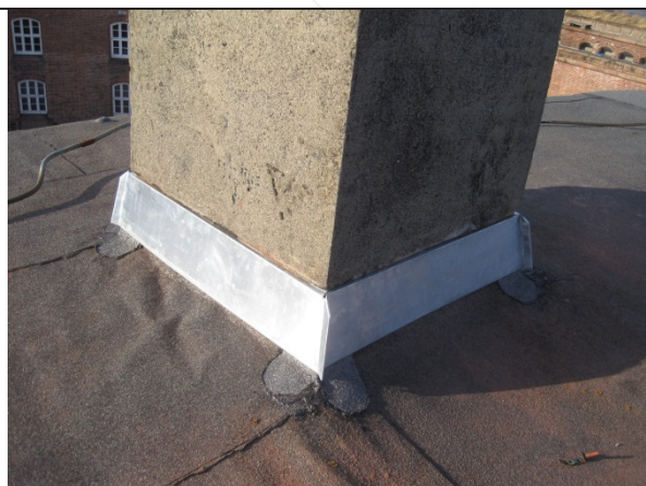
30.3.2012 Pipefotbeslag med vertikale hjørnefalser.
