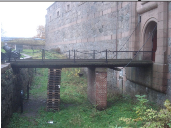
13.11.2009 Situasjonsbilde før oppstart.
