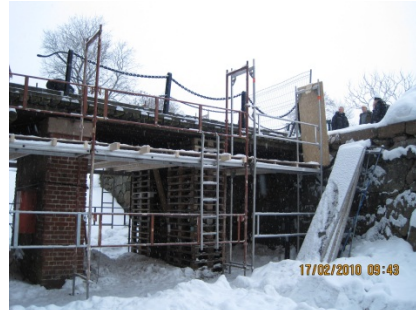
18.2.2010 Arbeidsplattform etablert.
