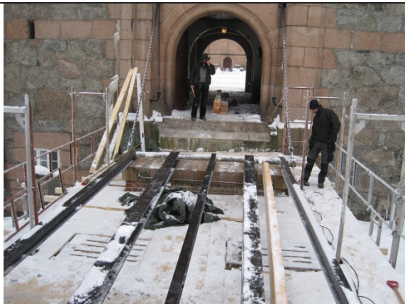
24.2.2010 Nye stålbjelker montert over arbeidsplattform
