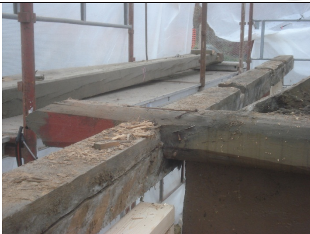
13.3.2009 Knutepunkt yttervegg/hanebjelke
