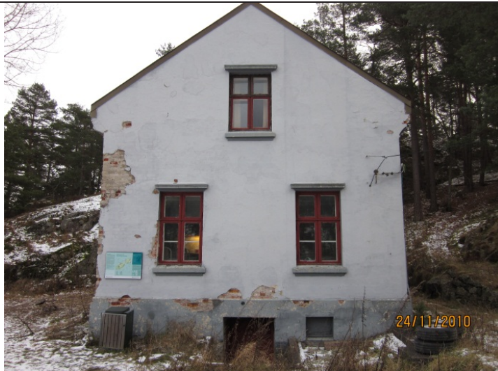
2010.11.24 Gavl mot vest hadde få skader, men mest hard sementbasert puss. For helhetlig utbedring ble den harde pussen fjernet.
