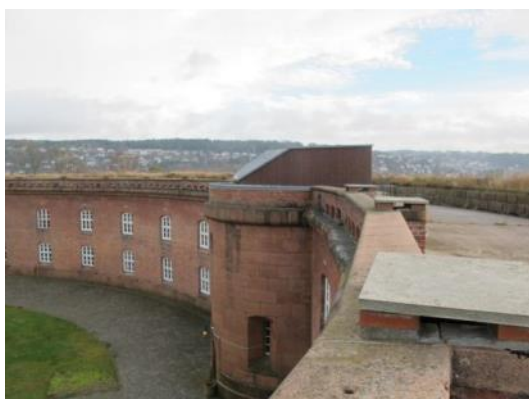
Taket på Hovedfortet før utbedring. Ballustraden i forgrunn.
