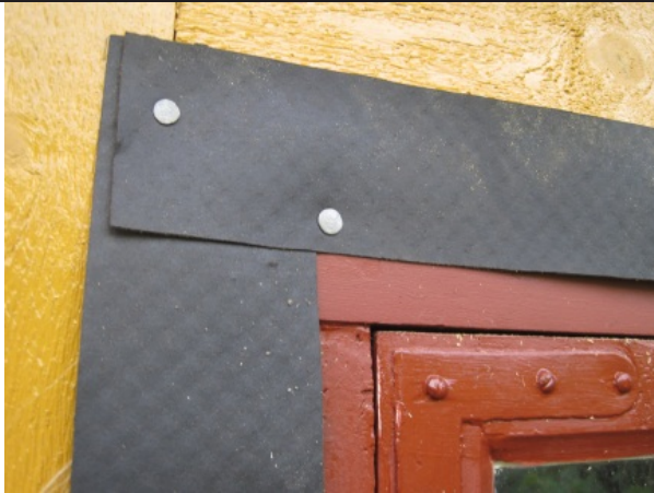
28.7.2010 Vindtetting under utvendige dekkbord mellom karm og bindingsverk
