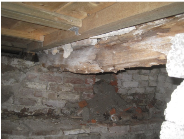
7.11.2011 Råteskader i gulvbjelker holdes under oppsikt. Mycoteam-rapport om tiltak følger vedlagt.
