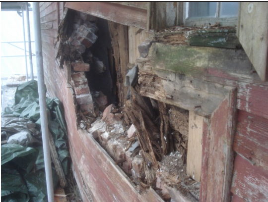
13.11.2009 Fjøsveggen mot sør
