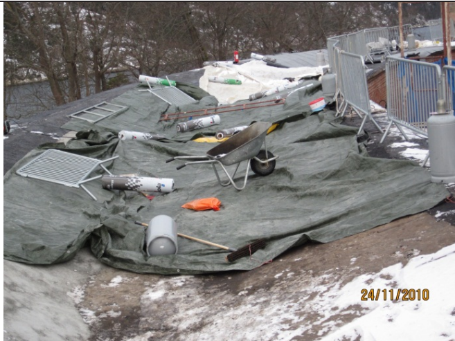
24.11.2010 Midlertidig tildekking mot nedbør og snø
