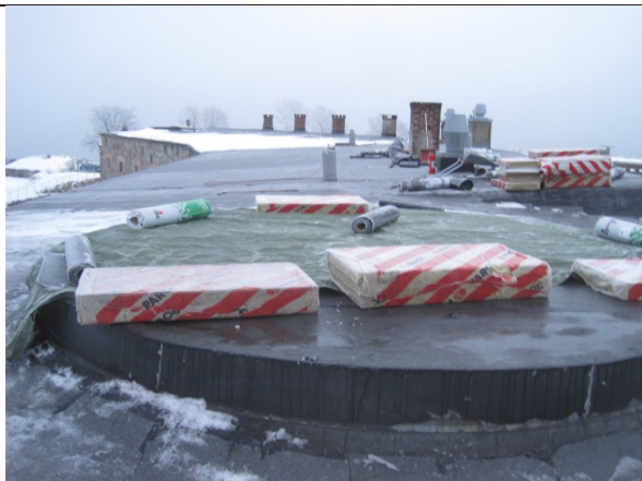
19.1.2011 Paroc mineralull som fallbyggende isolasjon på kanonpunkter.
