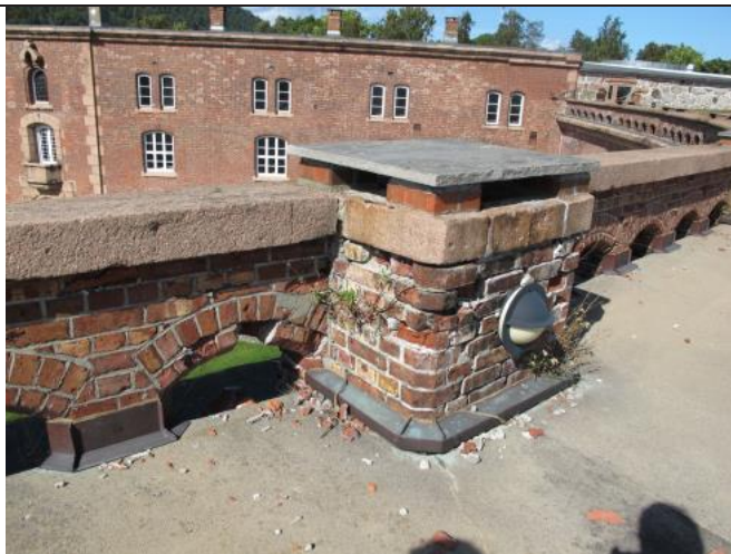
29.08.2012. Bildet viser typiske skader på tegl og fuger i ballustrade.
