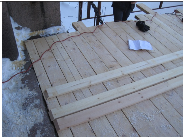
3.3.2010 Nytt brodekke montert. Langsgående slitebord under montering.
