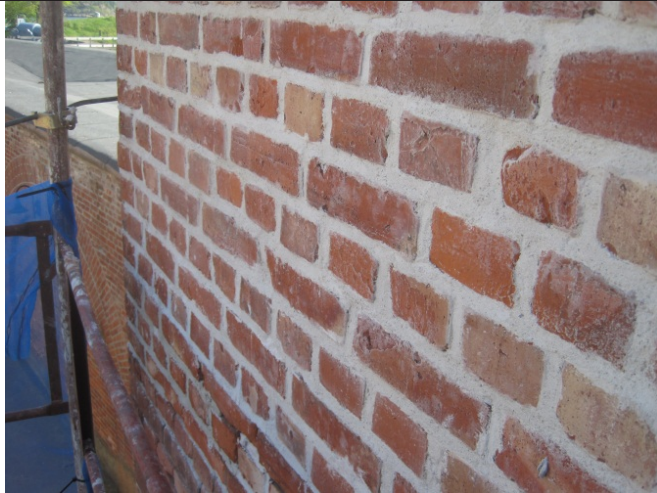
19.5.2010 Nærbilde etter utbedring
