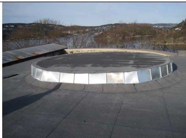
30.3.2011 Nye beslag. Ringbeslag med stående falser.
