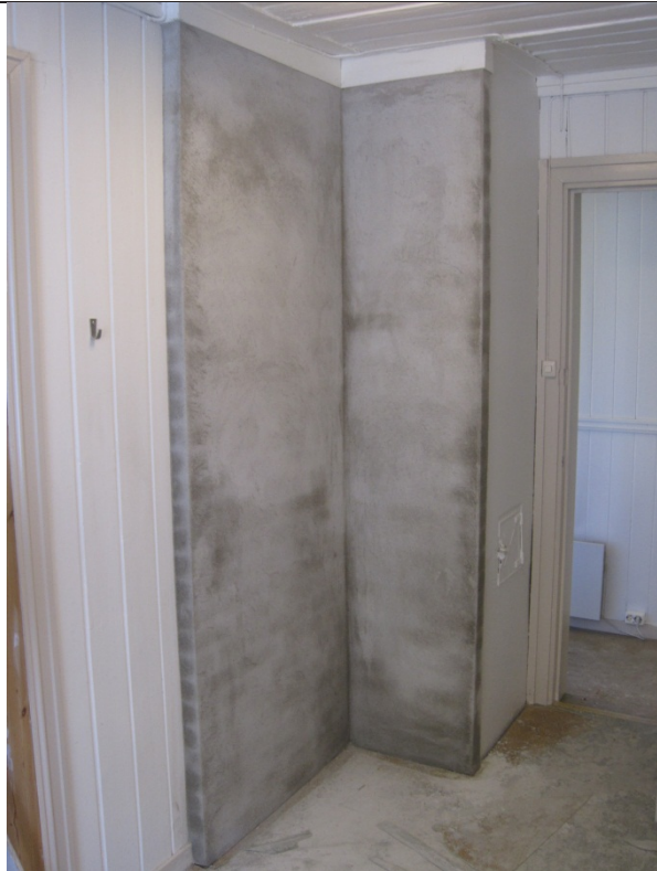
Brannvegger av teglmurverk ble pusset
