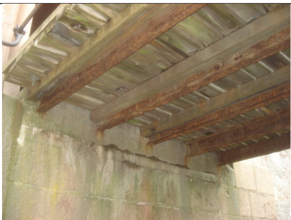
13.11.2009 Korroderede stålbejler før oppstart.
