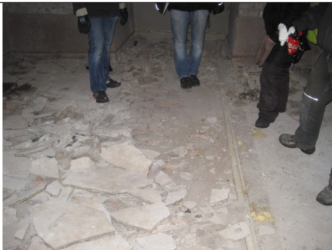
26.11.2010 Prøvepigging i gulv
