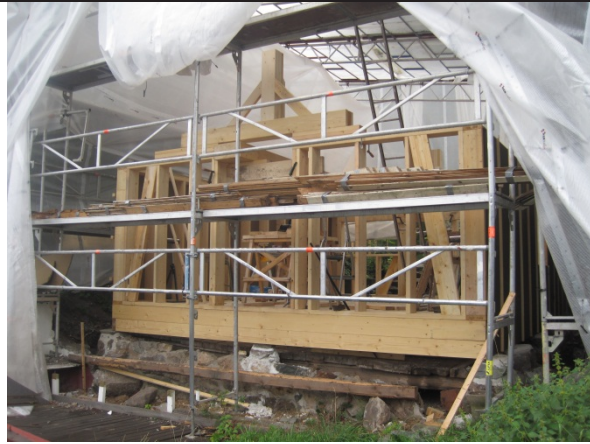
18.8.2010 Råbygg i gavl mot sjøen
