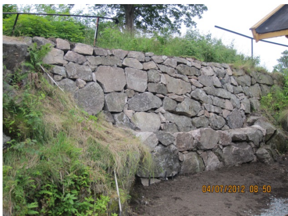
Mur ved smie, etter tiltak
