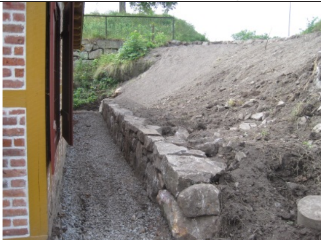
6.7.2011 Ettermontert steinkant mot skråning
