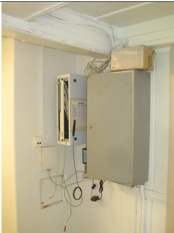
22.6.2011 Tavleskap ved oppstart
