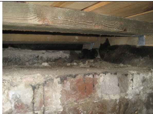
28.6.2011 Kryprom mot ringmur der det skulle innsettes flere lufteventiler.
