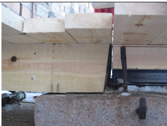
3.3.2010 Overgang mellom stålbjelker og tredekke i vindebru-delen.
