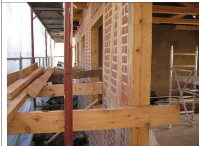
2010.05.12 Status for oppføring av bindingsverk og utmuring
