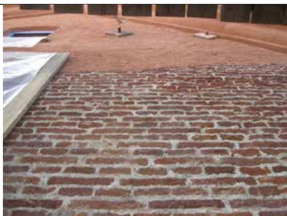
24.5.2012 Grunning nordre gavl pågår
