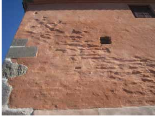
Fremelsket struktur fra underliggende murverk.
