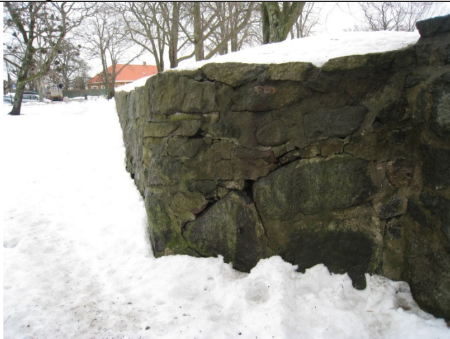
Oppsprekking av mur.
