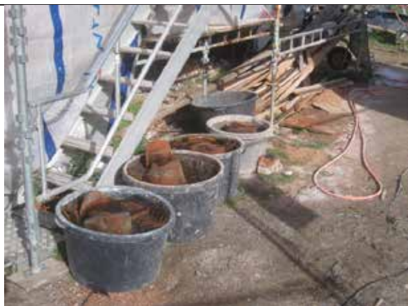
30.8.2012 Forvanning ved dykking i murerbøtter, av taktegl til kontraforter.
