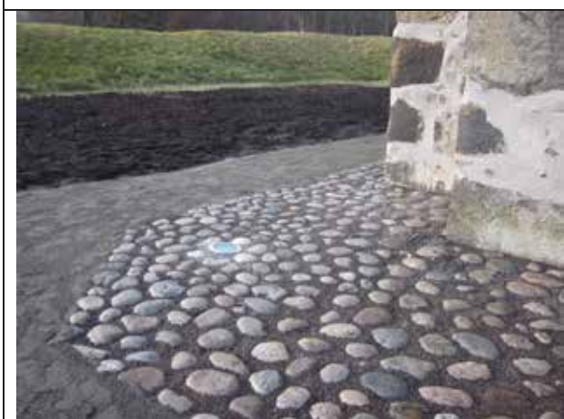
16.11.2012 Nedgravet armatur for fasadebelysning kan ses blant kuppelsteiner i utendørs belegning.
