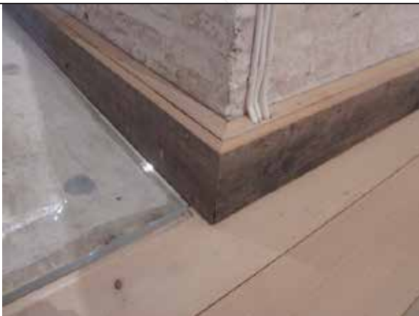
16.11.2012 Dekklister montert med gamleflaten ut.
