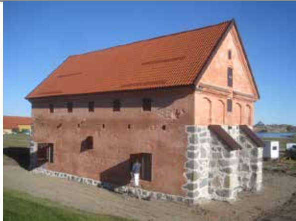
10.11.2012 Siste malingsstrøk på dører før trapper og utearbeid gjøres ferdig.
