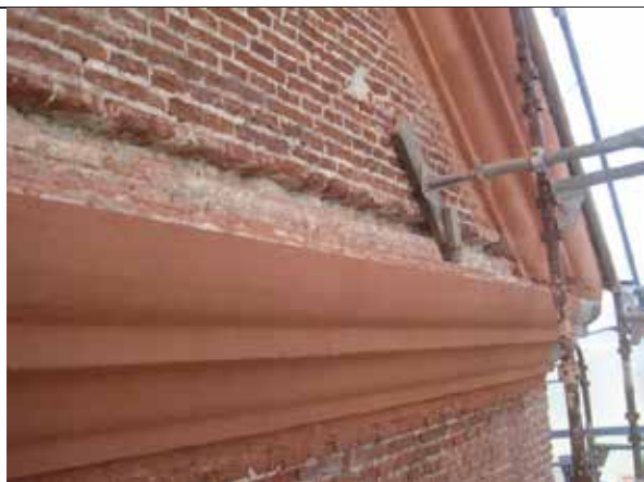
24.5.2012 Horisontal gavltrekning ferdig mot nord
