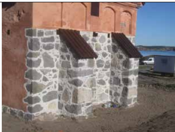
10.11.2012 Detalj fra gavl sør.
