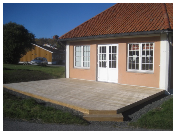
Med unntak av ny rømningsdør og treplattung
