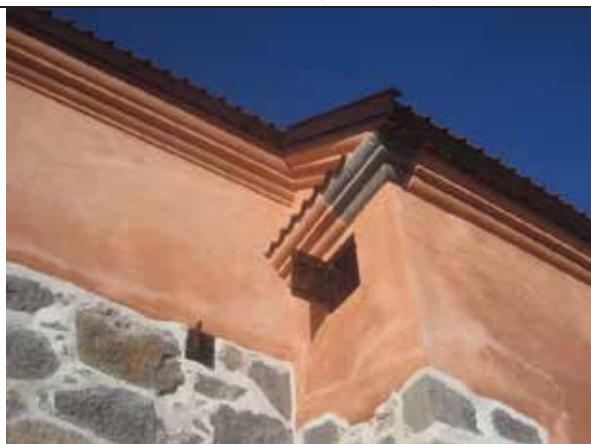
11.10.2012 Detalj ferdig utført arbeid.
