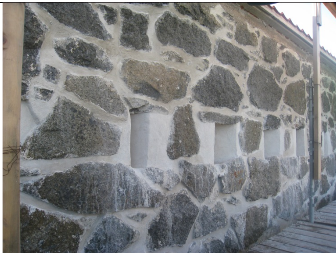
Nesten ferdig geværgalleri.
