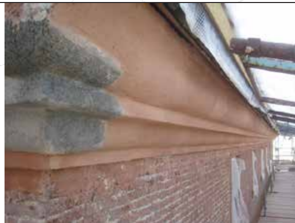
Avslutning mot hjørnestein skulle etter prøve som over foretas med rett kant som vist på bildet til venstre.
