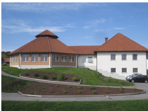
Kun innvendige arbeider utført.
