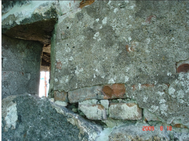
Før arbeidet startet.
