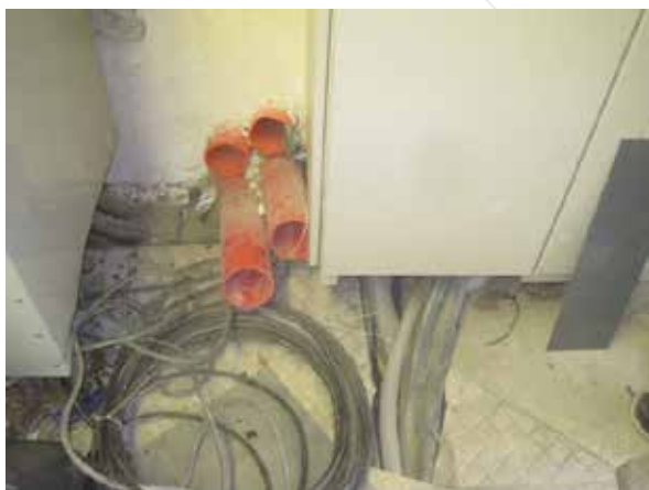
5.9.2012 Inntakspunkt i tavlerom i bygning 6, for strøm til bygning 5.
