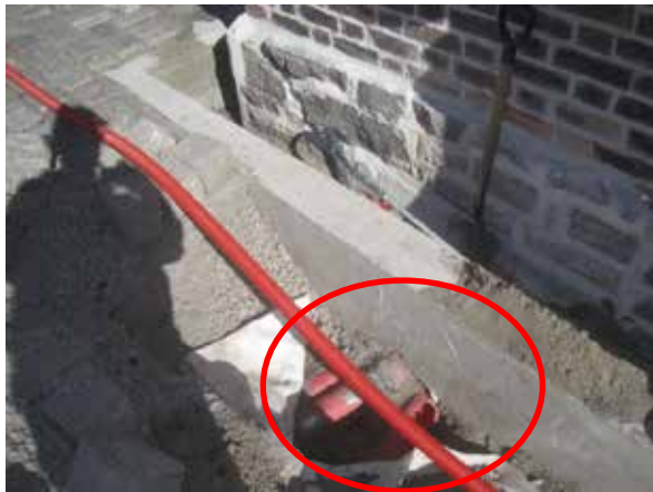
5.9.2012 Innføring av trekkerør for strøm til trafi i bygning 6.
