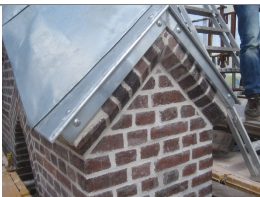
27.6.2012 Beslag på spir støttes av innvendig stang
