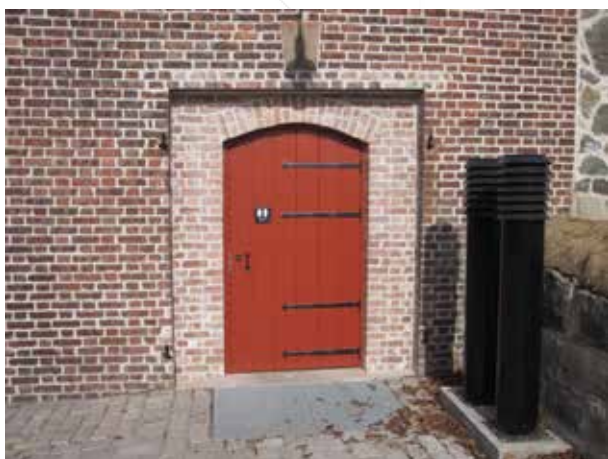
4.4.2013 Overtakelse. Svarte luftesøyler til høyre i bildet. Disse gir tilluft og utkast for ventilasjonsanlegget i teknisk rom.
