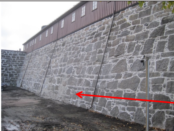
19.10.2011 Utbedring ferdig utside, inkl. to små ommurte partier.
