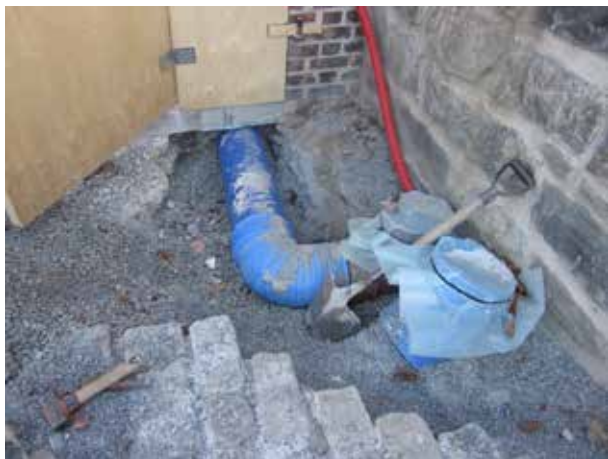
12.12.2012 Lufterør føres fra teknisk rom til utvendige søyler.
