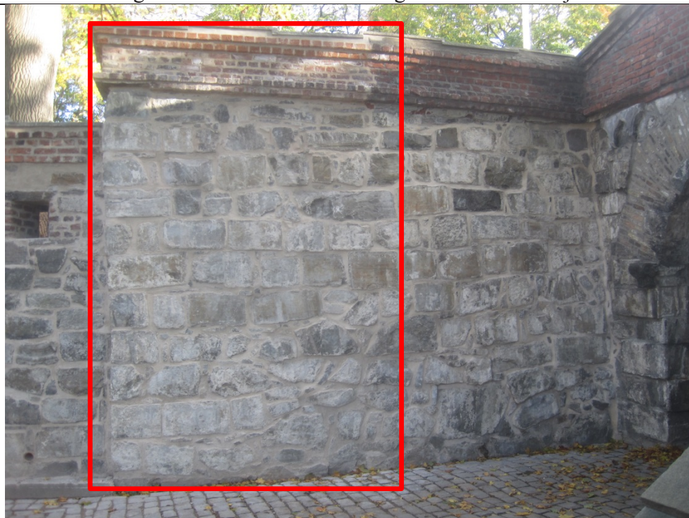
10.10.2012. Tildekking med presenning og stillas fjernet. Ommurt 3 m bredde markert.
