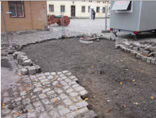
24.10.2012 Brostein ble tilbakeført etter at grøften ble lukket.
