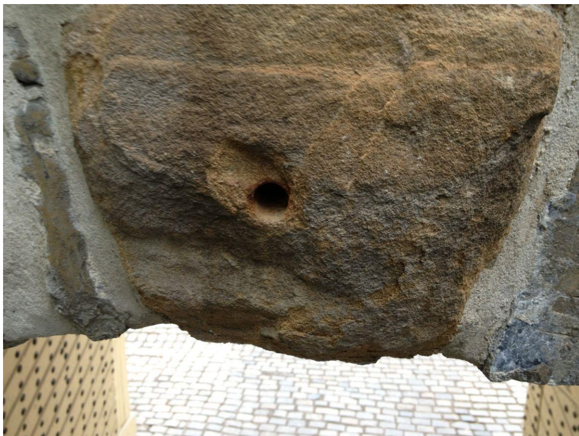
Figur 4. Nedre del er svært nedbrutt der overflatenes huggespor og eventuelle utsmykkingsdetaljer er borte. (Foto: NIKU 2013).
