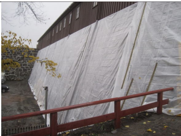
29.10.2011 Muren ble tildekket med presenning over første vinter
