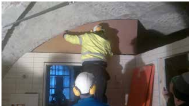
26.11.2012 Kontroll av maler for tilskjæring av glass over skillevegger.
