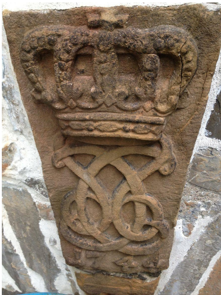
Figur 2. Kongemonogrammet består av to deler adskilt av en horisontal fuge. (Foto: NIKU 2013).
