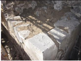
Muring med hydraulisk kalkmørtel.
