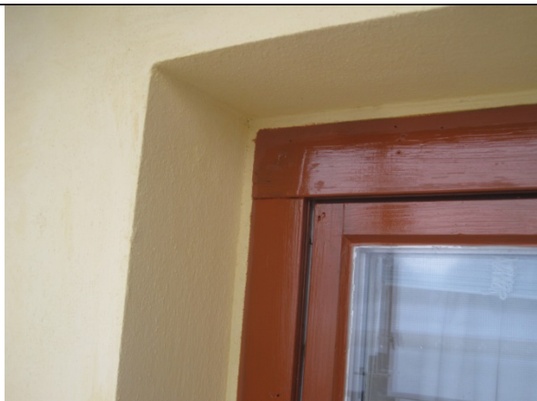
26.9.2011 Vegg og vinduer ferdig malt
