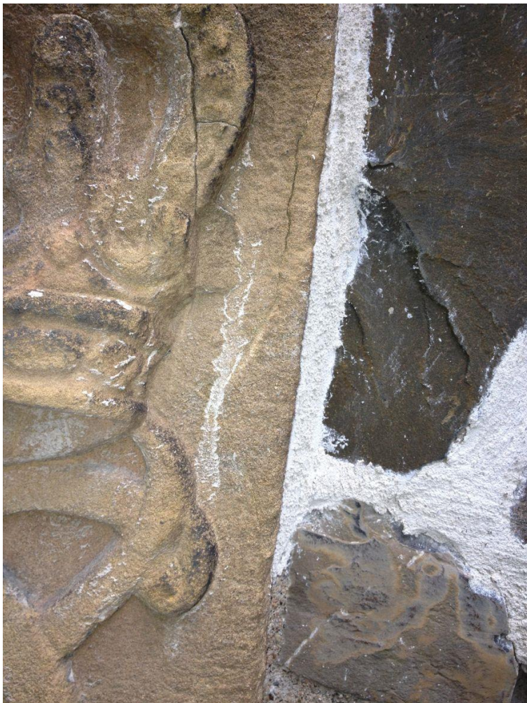
Figur 5. Før rensing var det mye kalksøl på overflatene. Dette ble fjernet ved hjelp av tørrens, skalpell og vann. (Foto: NIKU 2013).
