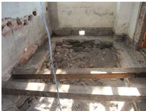
Før / under utbedring 04.06.2013
