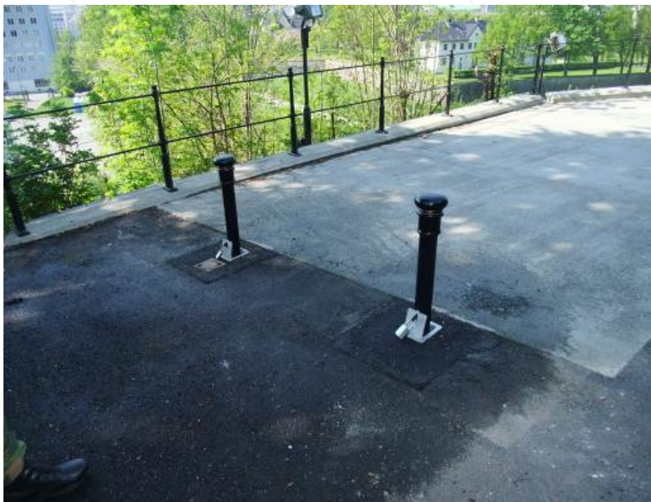
25.5.2012 Fysisk sperre med låsbare og avtakbare pullerter. Nytt rekkverk langs ytterkant av vei.
