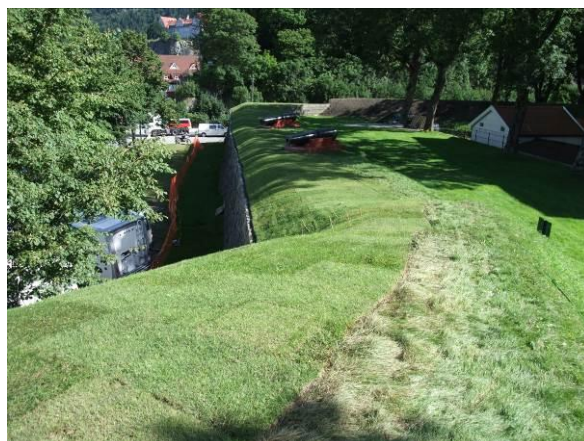
Etter utbedring 19.08.2010 Ballasttangens batteri / Nordpyntens batteri
