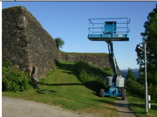
15.06.2009 Område 12.9 før utbedring. Lift er på plass for utbedring av øvre del av mur.
