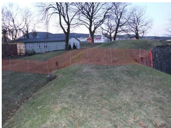
Før utbedring 17.12.2009 Ballasttangens batteri / Nordpyntens batteri
