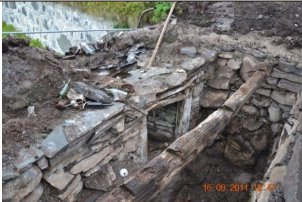
Portal ut gjennom ytre murskall
