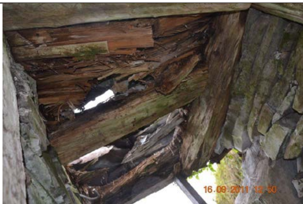
Råteskadet tak i portal sett nedenfra
