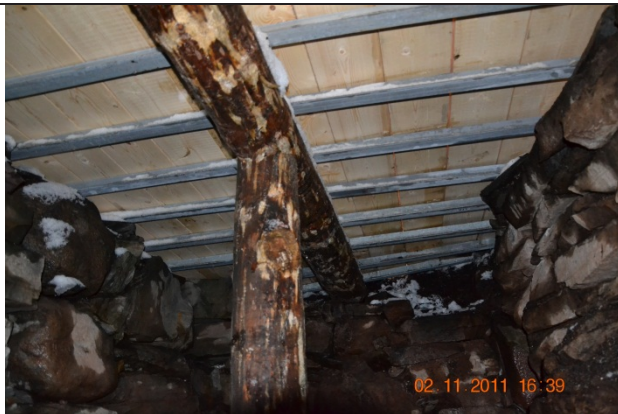
Reetablert kammertak sett nedenfra
