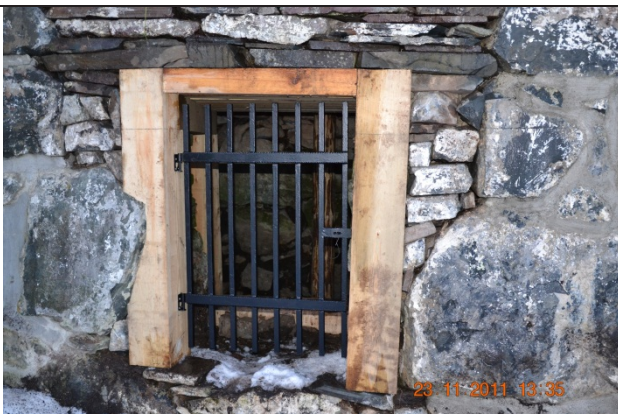
Ny port montert. Kan låses med hengelås.
