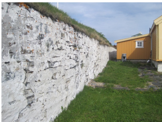
Før utbedring (24.06.2011), mur Øien.
