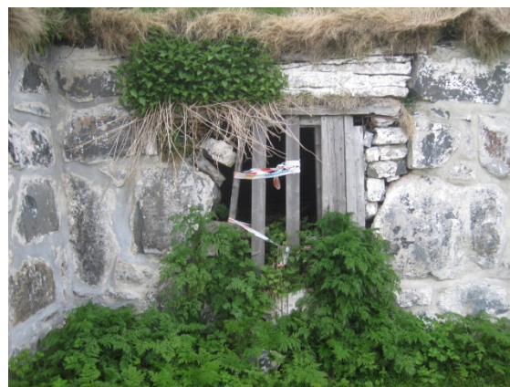
Før utbedring (24.06.2011) Latrinerom.
