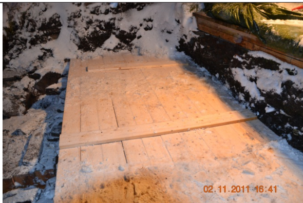
Kammertak sett ovenfra, før utlegging av Bentonit
