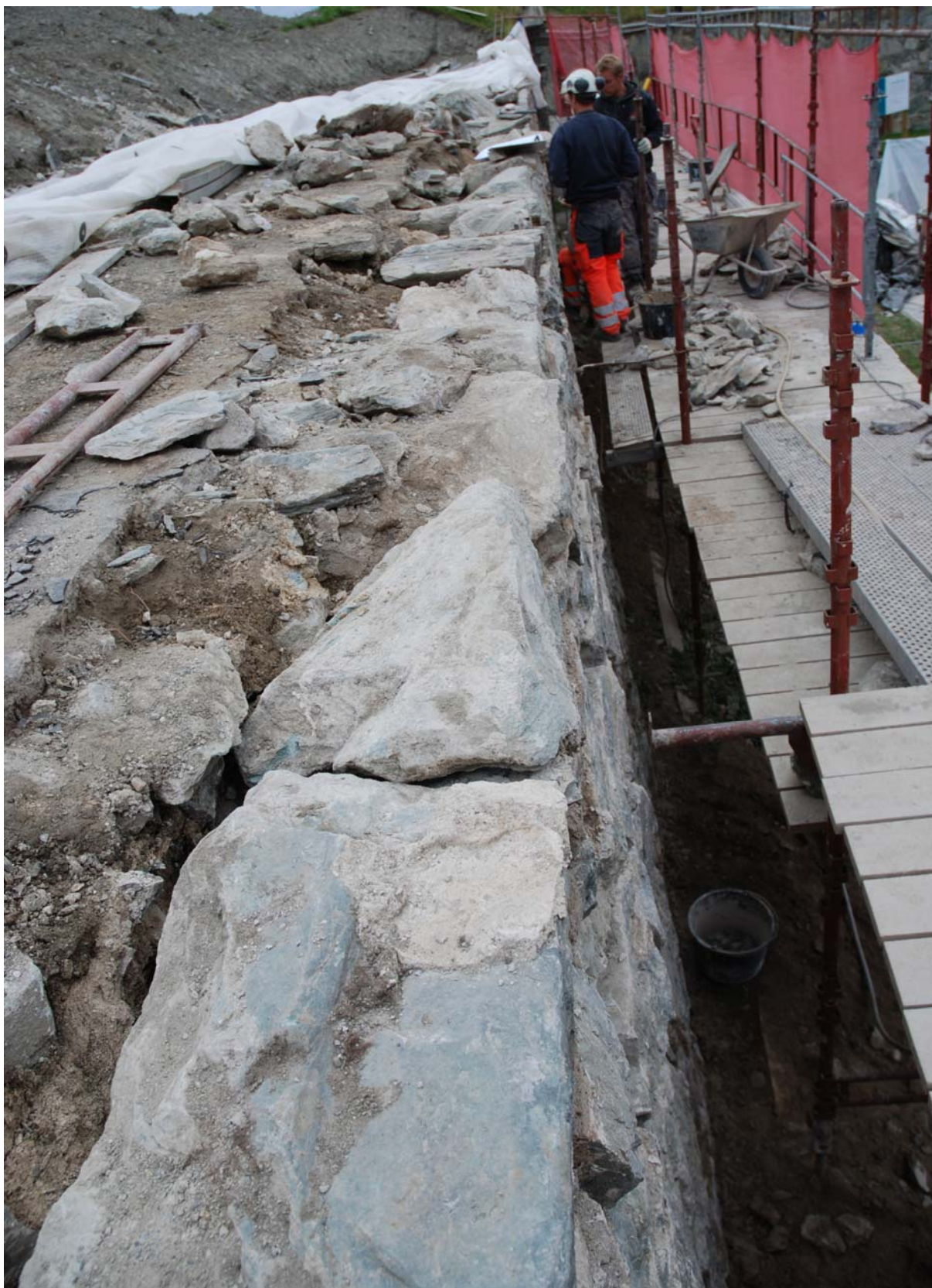
Foto 20091105_010 De øvre to skiftene ble demontert og murt tilbake, bildet er tatt under arbeidets gang på mur nummer 1.
