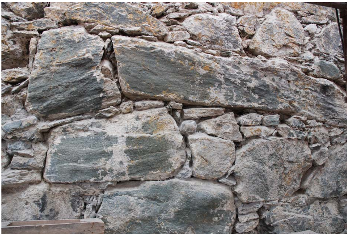
Foto 20091102_004 Detalj fra mur nummer 1, 1745-48 under arbeid med fjerning av sementbasert fugemateriale.
