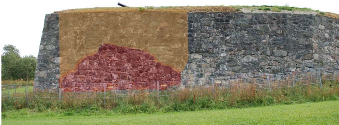
Foto 200911.19_023: Deformasjonen merket med rødt i nordvestre fase på mur nr 18 og område som må demonteres for å komme til deformasjonen er merket med oransje.
