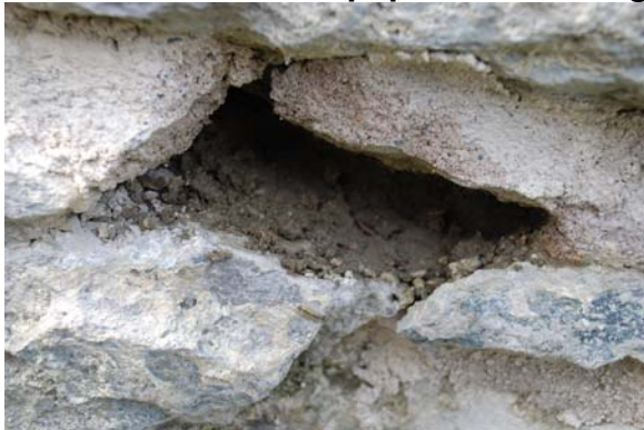
Foto 20091119_051 og _039 Bildet til venstre viser leire og jord i forbindelse med løs pinningsstein. Bildet til høyre viser gjenstående sement bak stein og tomrom bak fuge
