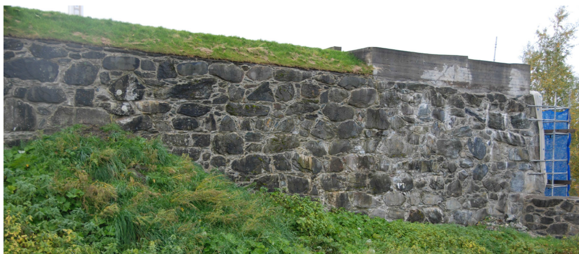
Mur nummer 16 ferdig spekket.
