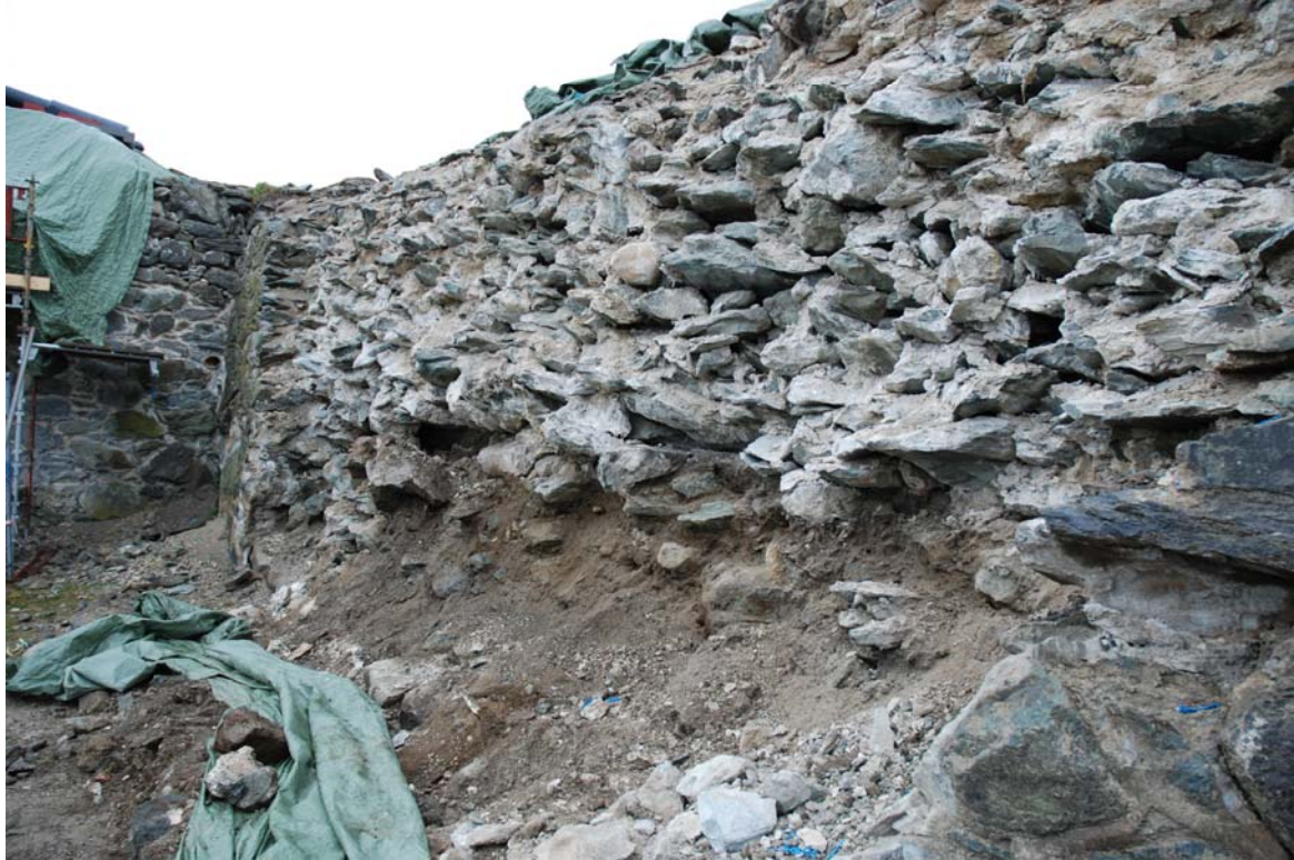
200911.07-004: Mur nr 5 etter at den ytre murvangen er demontert. Nedre del av murkjernen i midten var helt vasket ren for bindemiddel.
