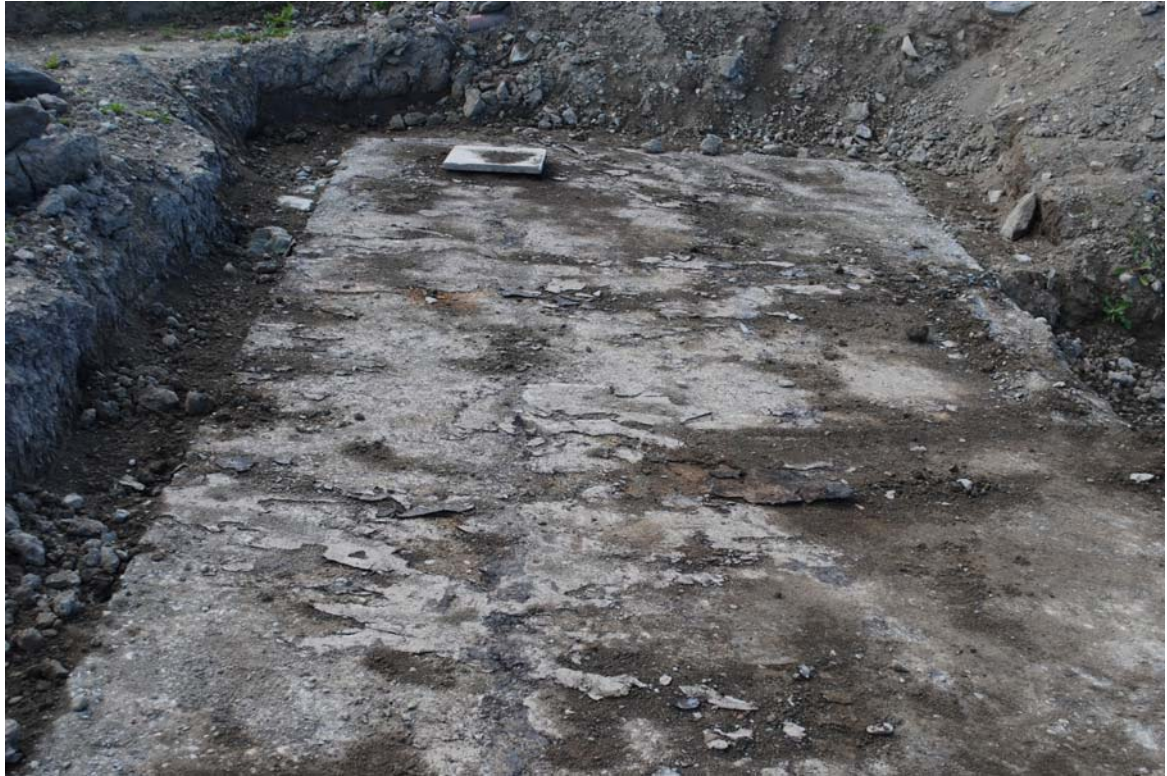
Fotonummer 200911.19_012 Toppen av kase matt med betongdekke.
