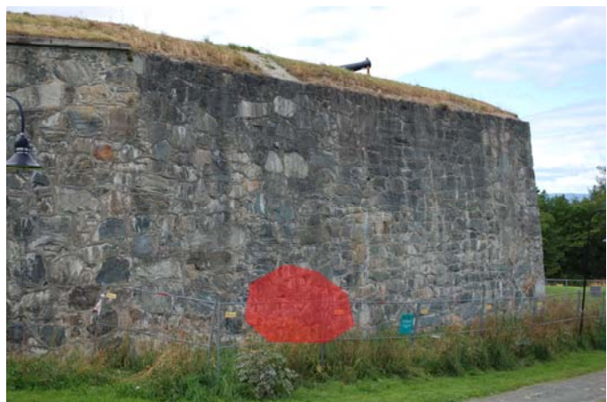
Foto200911.19_015: Deformasjonen merket med rødt i nordøstre fase på mur nr 19.
