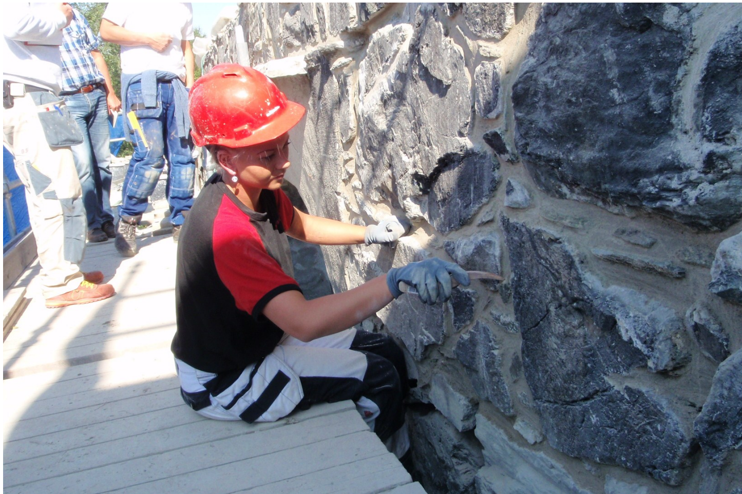
Foto: Kronprinsens batteri (mot vest) august 2012. Siste finpuss på kalkfugene.
