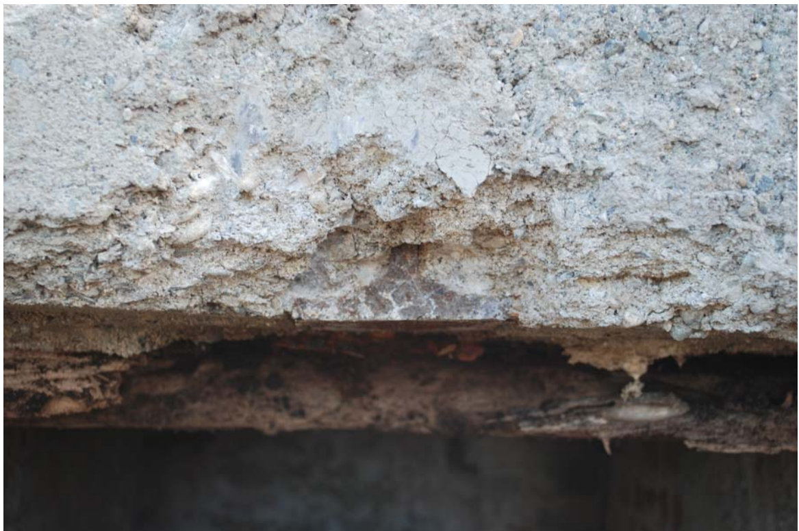
Fotonummer 200911.19_008: I-bjelke i betongdekket.
