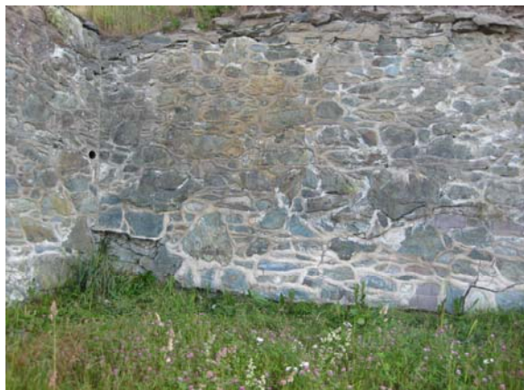
200911.08-003: Venstre del av mur før demontering.
