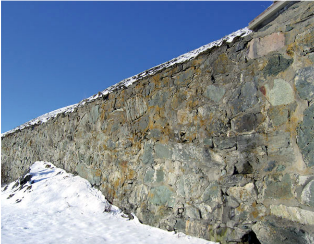
Foto Eide & Egeland as, viser situasjonen før inngrep i 2009
