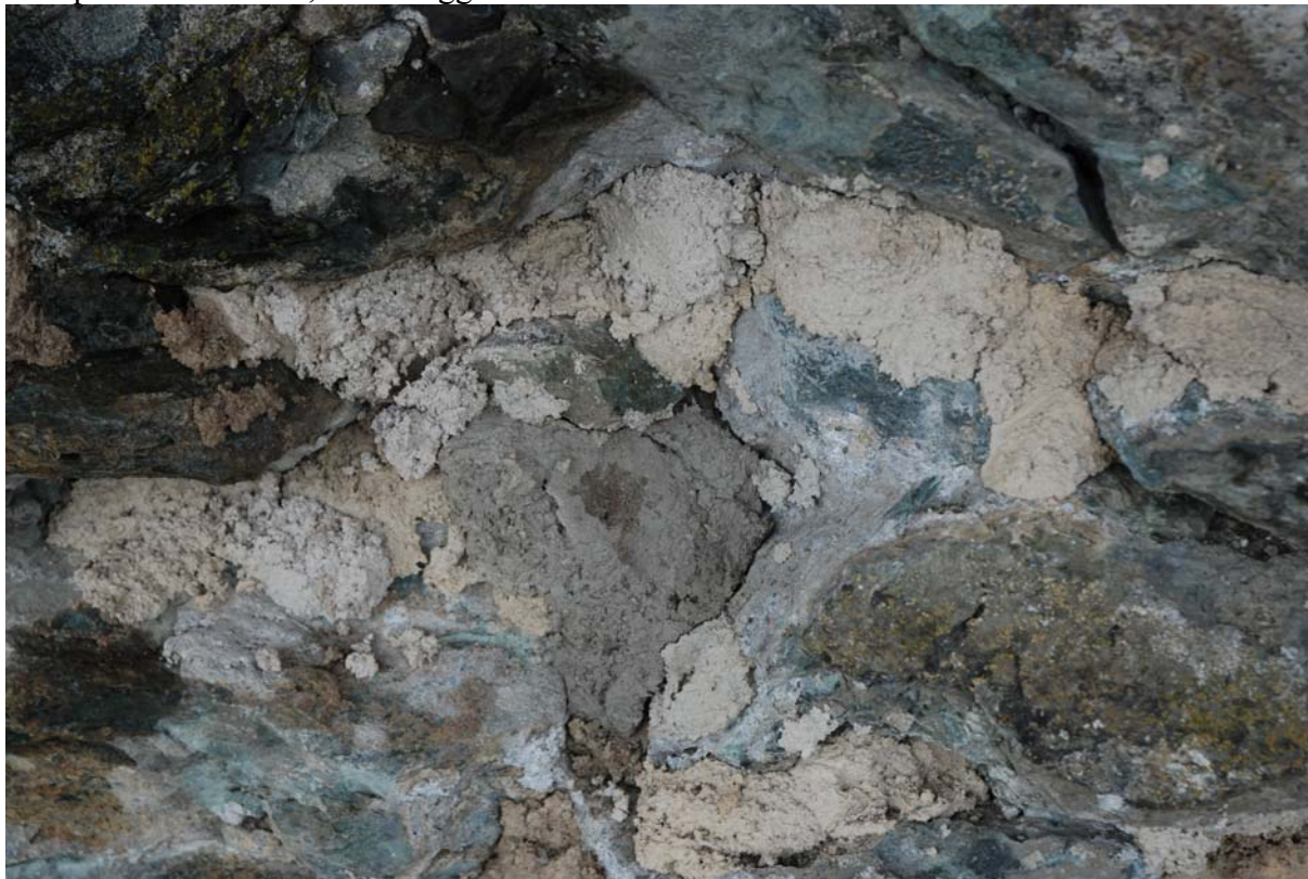
Foto 20091107_018 Påviste fargeforskjeller i en og samme type mørtel
