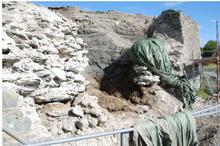
200911.05-020: Etter demontering av midtre murkjerne på mur nr 5.
