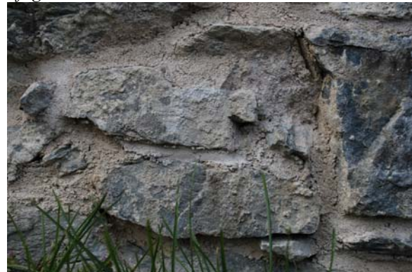
Foto 20091119_044 og _045 Bildet til venstre viser dårlig komprimering mellom fuge og stein. Bildet til høyre viser mangelfull slutføring av fuge.
