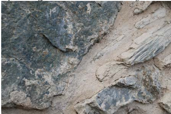
Foto 20091119_044 og _045 Bildet til venstre viser dårlig komprimering mellom fuge og stein. Bildet til høyre viser mangelfull slutføring av fuge.
