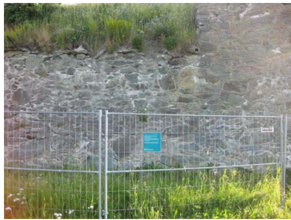
200911.08-001: Høyre del av mur nummer 5 før demontering.
