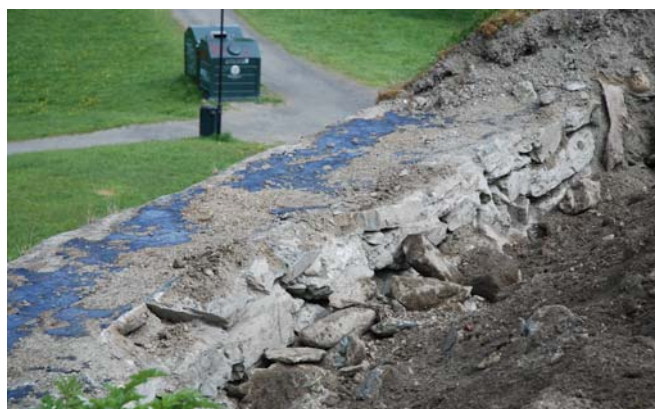
Foto 200911.14_009: Snitt ved sprengningsulykke.
