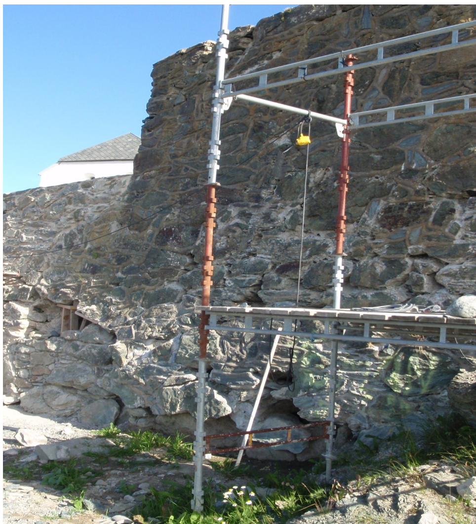
Foto: Kronprinsens batteri (mot vest) august 2012. Siste finpuss på kalkfugene.
