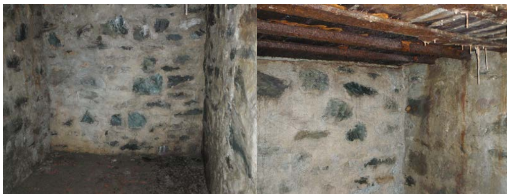
Vegger av spekket naturstein, teglsteinsgulv Himling med stålbjelker og plank
