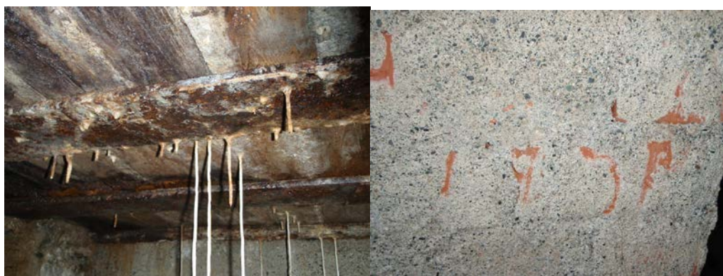
Rustne bjelker, mellomliggende plank
