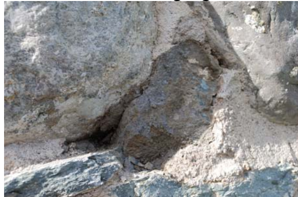
Foto 20091119_051 og _039 Bildet til venstre viser leire og jord i forbindelse med løs pinningsstein. Bildet til høyre viser gjenstående sement bak stein og tomrom bak fuge
