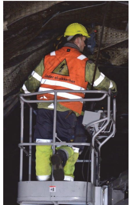
Beredskapsvakt høyspenning Foto: Øystein Grue
